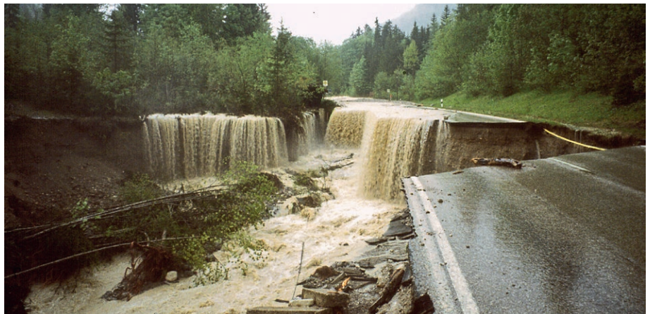
Hochwasser der Weißbach (Pfingsten 1999)
