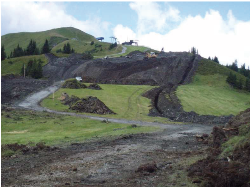
Abb. 21: Leitungsbau im hochmontanen Erschließungsgebiet am Kreuzkogel (Pongau/Salzburg). (Foto: http://www.banff.it/wp-content/uploads/2015/12/ImpattoSci-Skipiste-Neu-von-Sonnenbahn-Ri-Kreuzkogel-vorher.jpg ).
