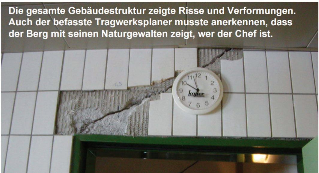
Abb. 20: Spezialprobleme der Höhen-skigebiete: Mauerrisse im Bergrestaurant Pardatschgrat der Silvretta-Arena/ Tirol durch eingriffsbedingtes (?) Abtauen des Permafrostes.
