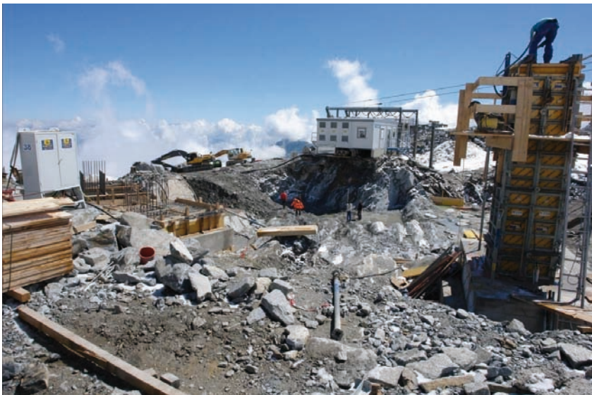
Abb. 45: Bau der Mittelstation Gletscherjet am Kitzsteinhorn/Hohe Tauern 2016. Tiefgründige Felsaufräumungen wie hier sind gleichzeitig mit Eingriffen in den Permafrost verbunden, dessen Verlust zu neuen Hanglabilisierungen an unerwarteter Stelle führen kann. Auch eine ökologische Bauaufsicht ändert nichts an der Tatsache, dass derartige Eingriffe alpinökologisch nicht statthaft sein sollten. (Foto Jb. ökol. Bauaufsicht Gletscherbahnen Kaprun AG, 2016).
