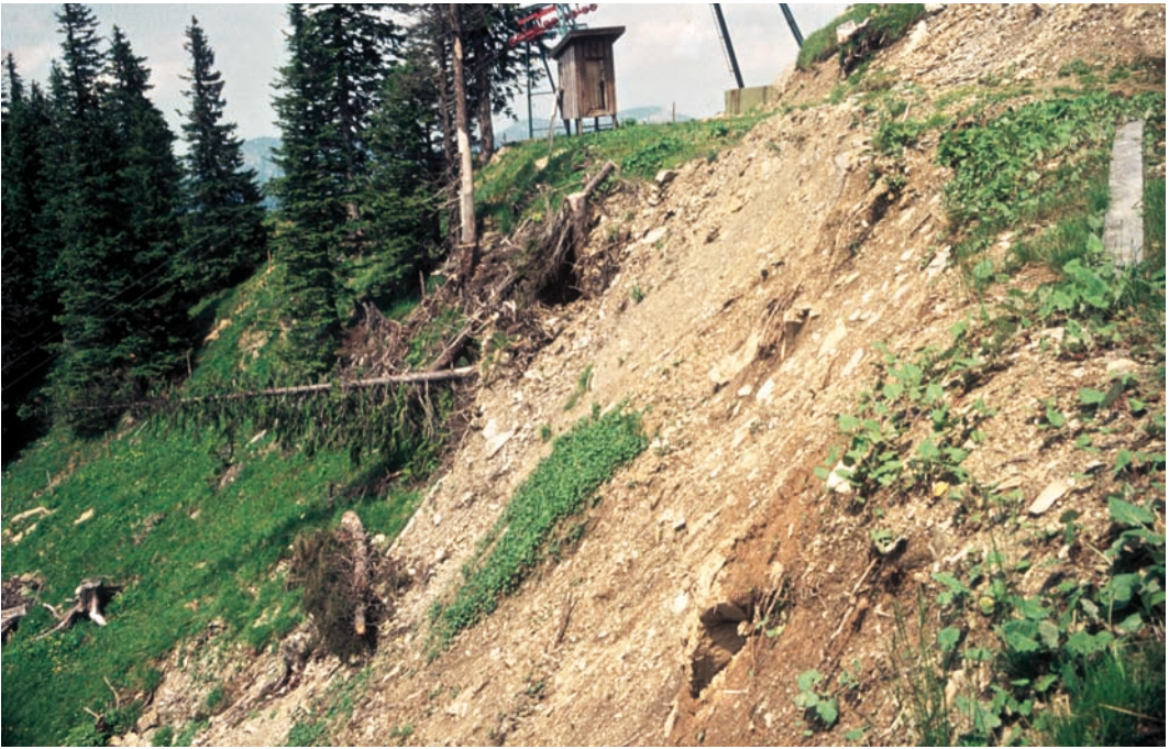
Abb. 38: Hangrutschung (Pistenbaustelle) Bereich Riedberger Horn/Allgäu. (Foto T. Schauer, 7/1975).
