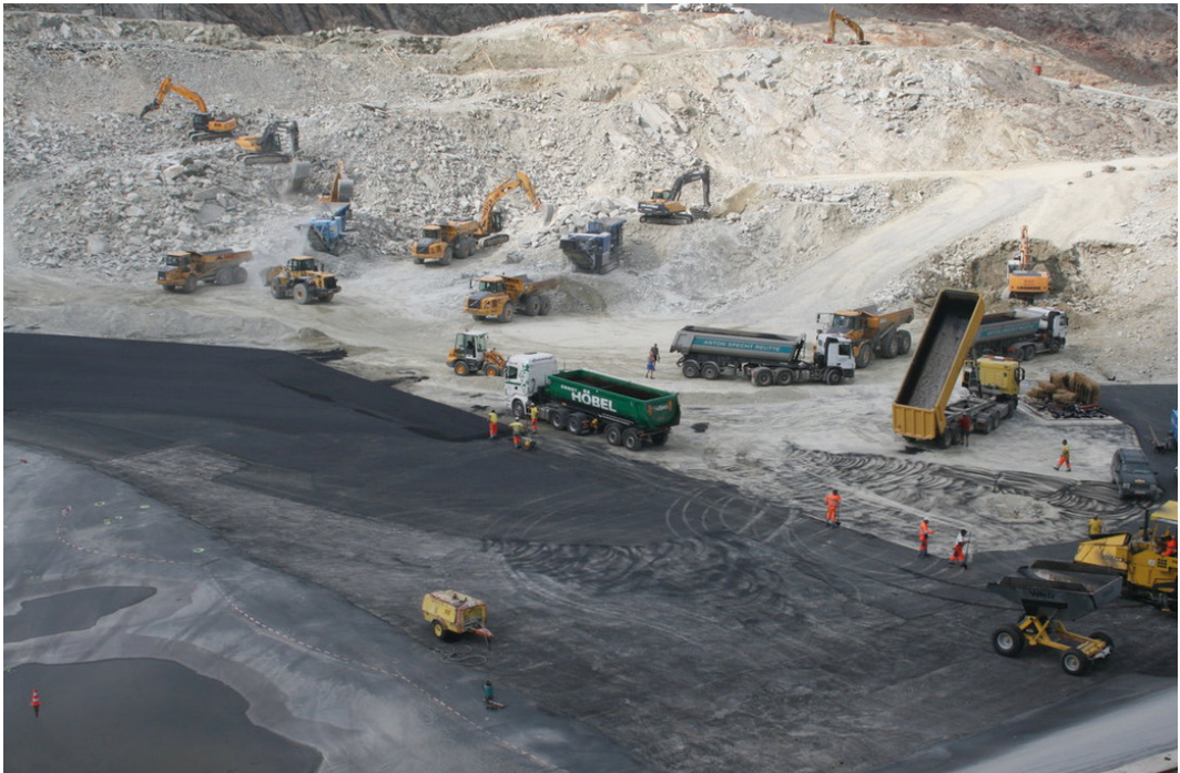
Abb. 19: Bau des Rettenbachferner-Beschneigungsspeicherbeckens im Skigebiet Hochtöztal (Tirol). (Foto: http://www.meinbezirk.at/imst/wirtschaft/neues-rueckgrat-fuer-soeldens-beschneigung-m45984,4822.html ).
