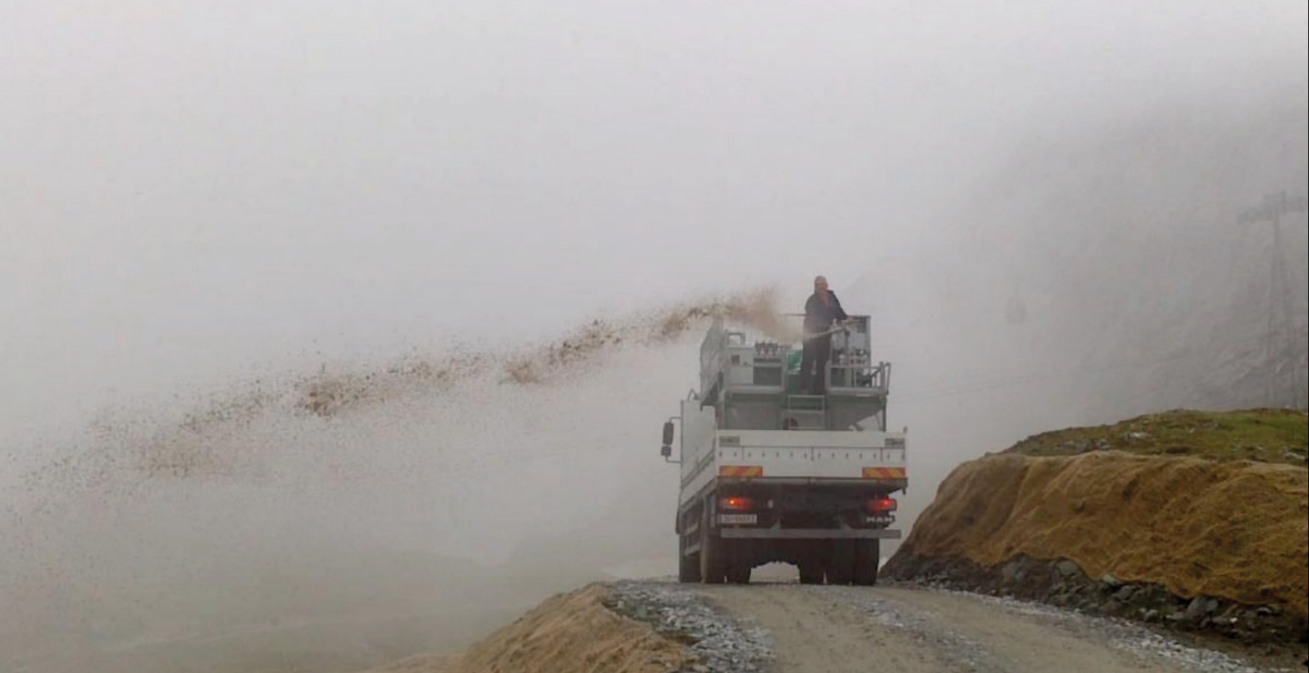
Abb. 5: LKW-Straße im Skigebiet Kitzsteinhorn/Kaprun (Hohe Tauern). Ohne sie könnte z.B. die Hydrosaat der Schadflächen im Bereich der Pumpstation Langwiedboden III/IV nicht durchgeführt werden. (Foto: Gletscherbahnen Kaprun AG, Jahresbericht 2014).
