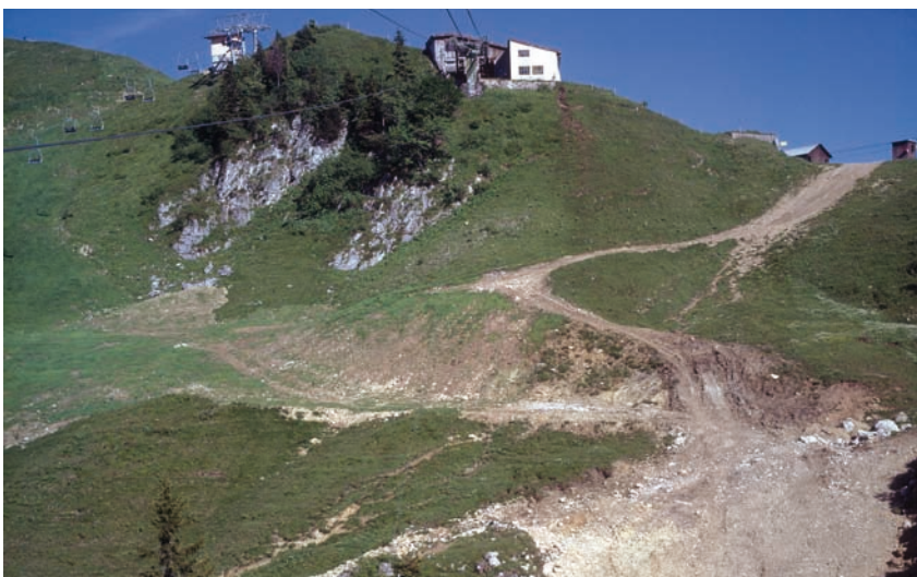
Abb. 37: Hangrutschung (Pistenbaustelle) Garlandhang/Brauneck/Obb. (Foto T. Schauer).
