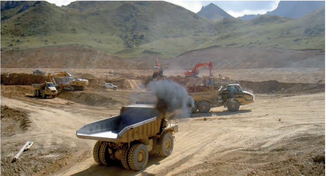
Abb. 27: Geländeänderung für ein großes Schneewasserreservoir im Skigebiet Arrondiaz/Hochsavoyen 2007. (Foto aus PACCARD (2010)).
